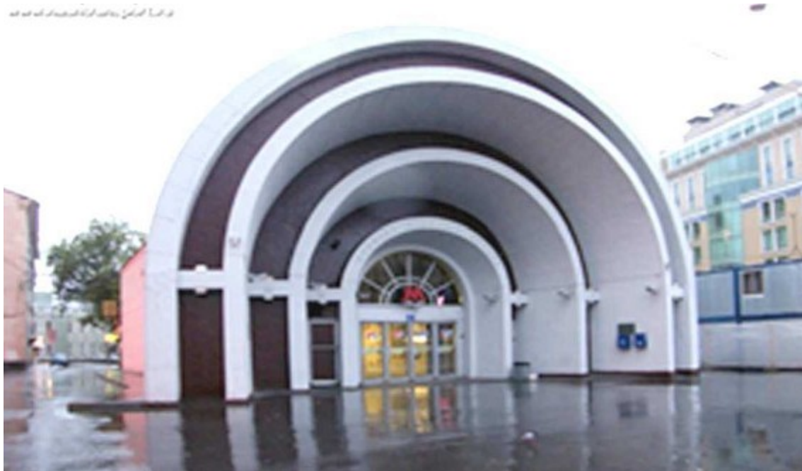
Вестибюль станции метро «Красные ворота», (арх. Н. А. Ладовский, 1938 г., Москва)
